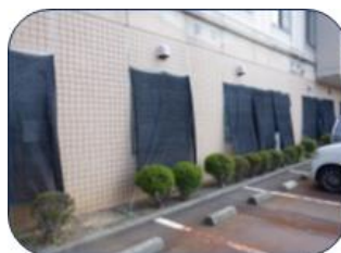
〈遮光ネット設置〉
